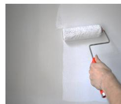
Rifinire con stesura di pittura traspirante a base silicati di potassio
