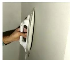
Stendere una sottile mano di rasante con una spatola liscia e lasciare asciugare completamente
