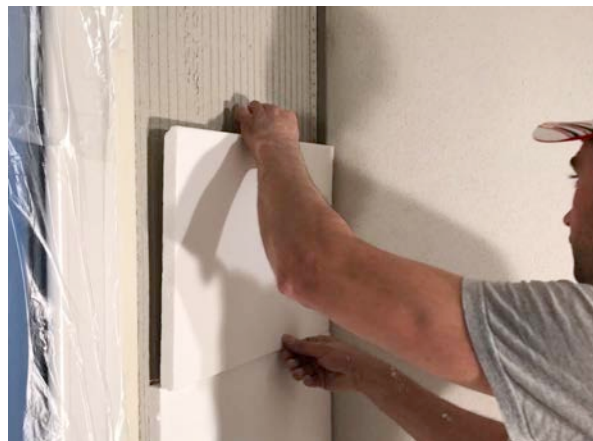
Posa di pannelli Thermosilex a parete
