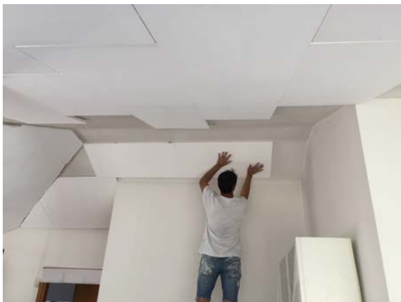
Posa di pannelli Thermosilex a soffitto
